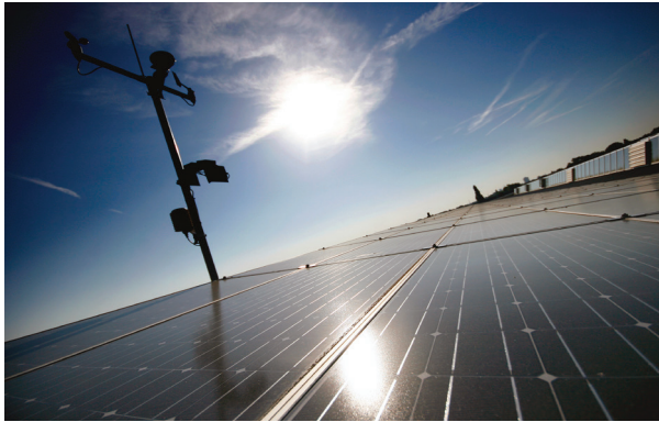
Die Photovoltaikanlage Leinhausen erzeugt 250 Kilowatt Leistung in der Spitze, die direkt ins Fahrleitungsnetz eingespeist werden.
