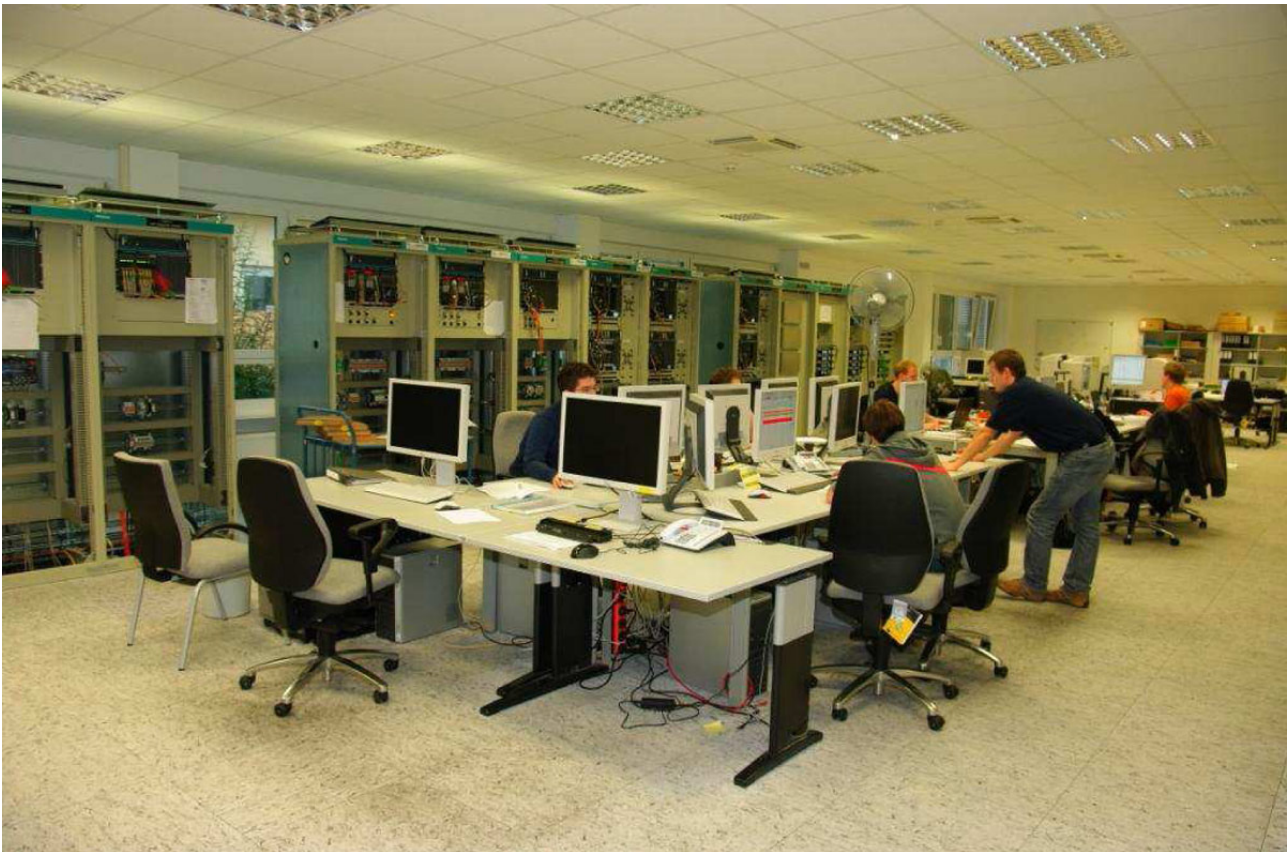
Beispiel eines Functional Performance Test (FPT) in Erlangen
