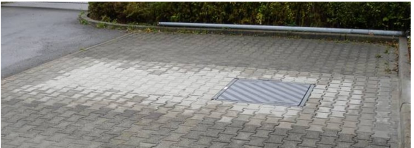
Abbildung 75: Induktiver Ladeplatz im Außenbereich
