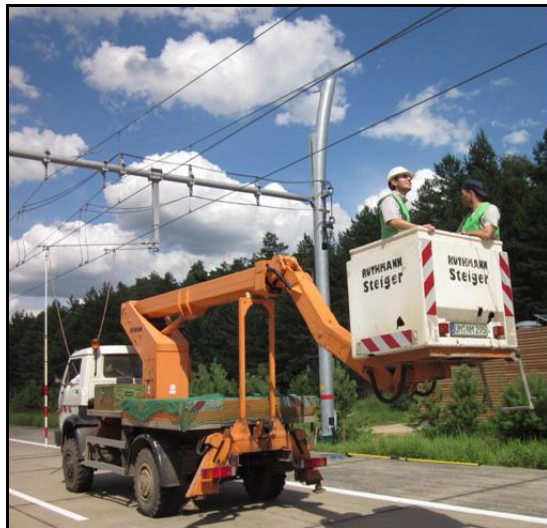
Abbildung 3-26 Fahrleitungsinspektion mit Hubsteiger
