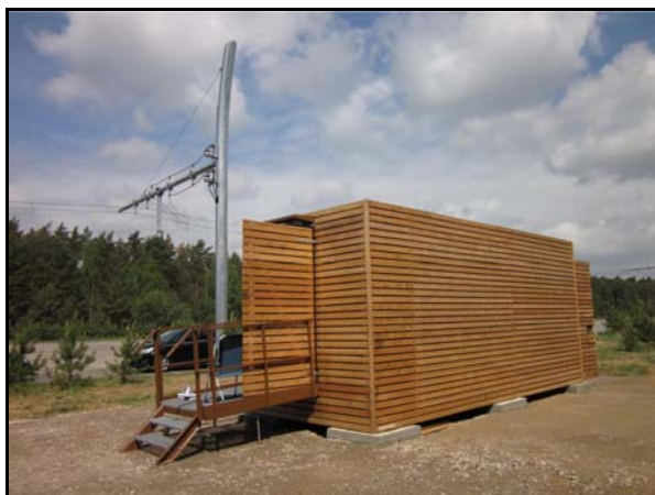
Abbildung 3-8 Gesamtansicht Uw-Container mit Holzverkleidung
