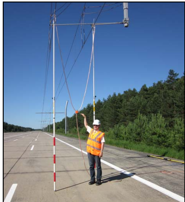
Abbildung 3-20 Kontrolle der Schutzmaßnahmen zur Arbeitssicherheit
