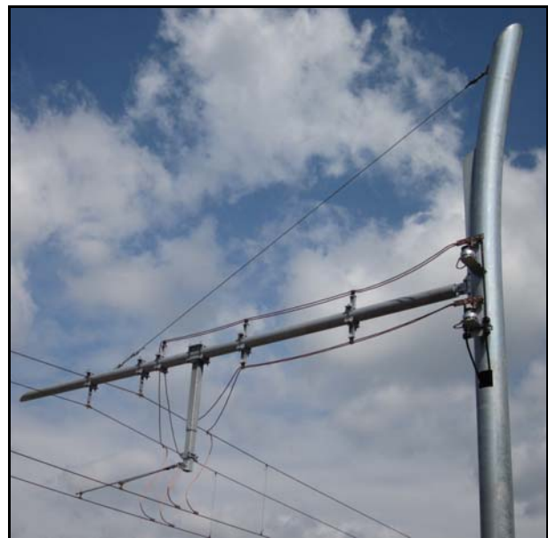
Abbildung 3-11 Einspeisemast mit zweipoliger Einspeisung
