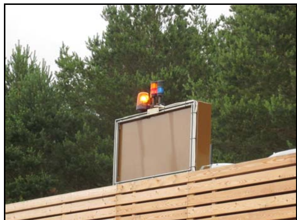
Abbildung 3-9 Signalleuchten und akust. Alarmgeber auf Uw-Dach
