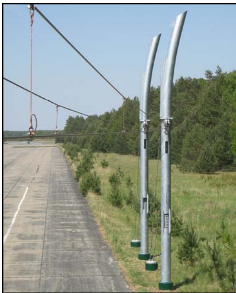
Abbildung 3-10 Nachspanneinrichtung mit Gewichten im Mast
