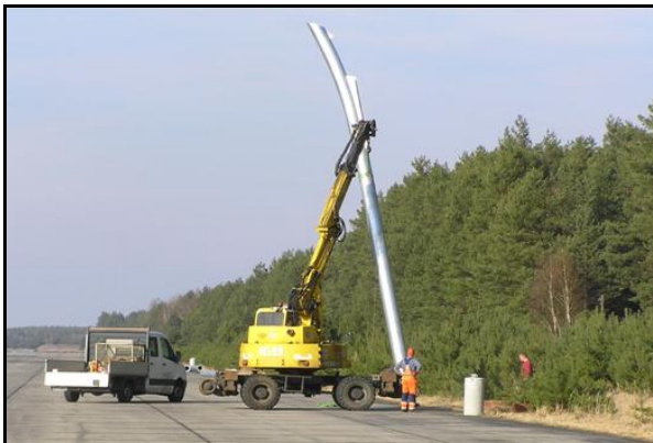
Abbildung 2-16 Aufstellen der FL-Maste
