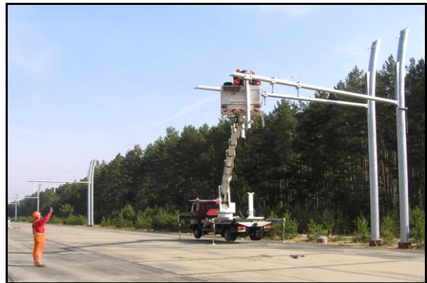
Abbildung 2-17 Auslegermontage für die FL
