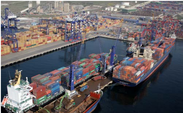
Typisches Container-Terminal mit Terminal Trucks und Portalkranen im Lagerbereich
