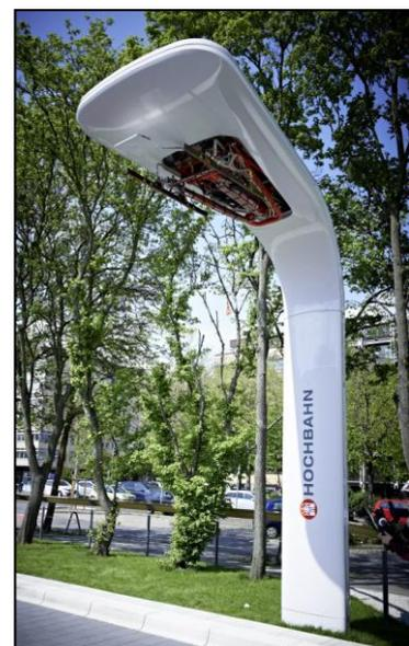
Messungen am 10. August 2016 haben ergeben, dass die Batteriebusse die Ladeleistung von 300 kW bei jedem Ladevorgang voll ausnutzen und dass der Wirkungsgrad über das gesamte System, von der Mittel-, über die Niederspannung, bis hin zur Ladegleichspannung bei 93% bis über 97% liegt. Somit ist diese Energieübertragung als ein sehr wirtschaftliches Ladesystem zu bewerten.
