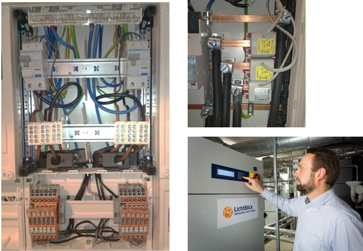
Abbildung 6: Unterverteilung mit Klappstromwandler und Prüfklemmen für die Messtechnik der dezentralen Optimierung (links) sowie die unabhängige Messung des gesamten Verbrauchs für die Eigenregelung des stationären Batteriespeichers (rechts, oben) und das BHKW im Vogelhüttendeich (rechts, unten).
